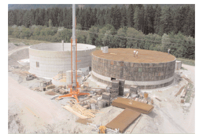
AAE Biogasanlage I im Bau – 500 kW elektrische Leistung und 4 Mio. kWh Jahreserzeugung
