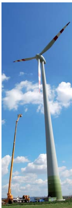
Attraktion beim Eröffnungsfest: Mit der 60 Meter hohen Teleskopbühne gelangen Besucher in luftige Höhen. Nähenhöhe 113 m, Rotordurchmesser 71 m, Nennleistung 2 MW
