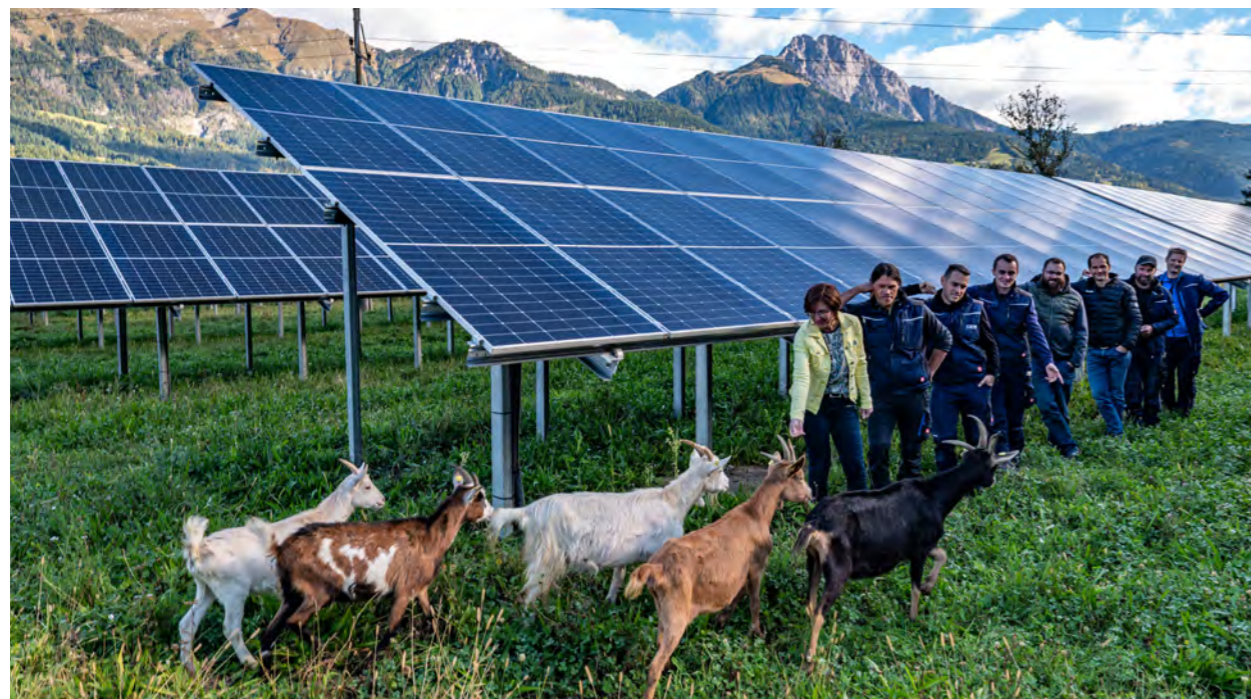
Agri-PV-Anlage der AAE in Weidenburg
