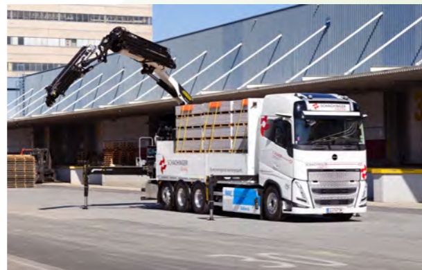
Erster vollelektrischer Baukran in Österreich
